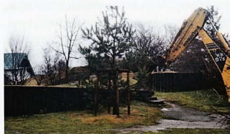
Odpaliště č. 4 krátce před rekonstrukcí...
