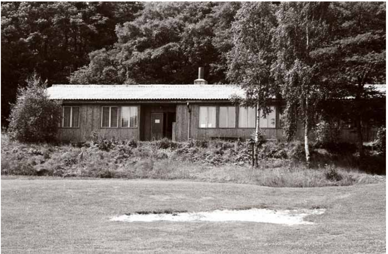
TESKO-objekt „provizorní“ klubovny GCP, sloužící svému účelu od kolaudace v r. 1975 do současnosti... (podobnost s vojenskými baráky na fotografii z 20. let je čistě náhodná)
